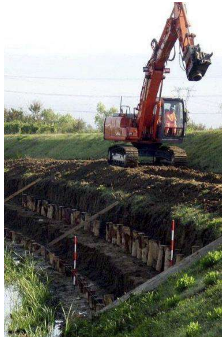
Opere di rinforzo degli argini curate dai Consorzi di Bonifica (Foto di repertorio)
